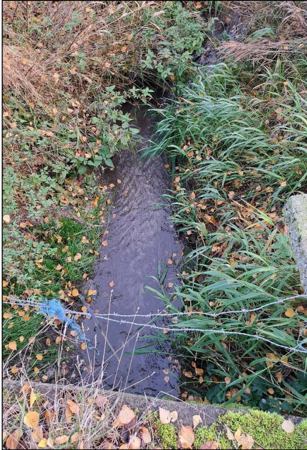
Abbildung 6: Bachaustritt aus der Verrohrung
