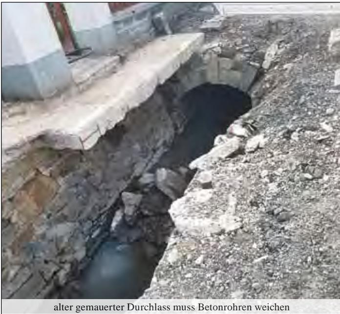
alter gemauerter Durchlass muss Betonrohren weichen
