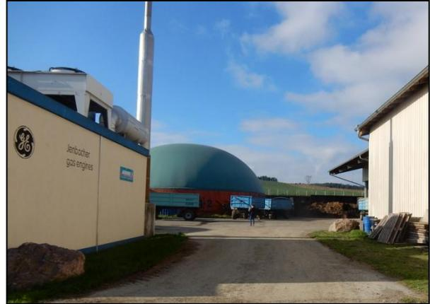
Abbildung 7: Blockheizkraftwerk (links im Bild) und Fermenter
