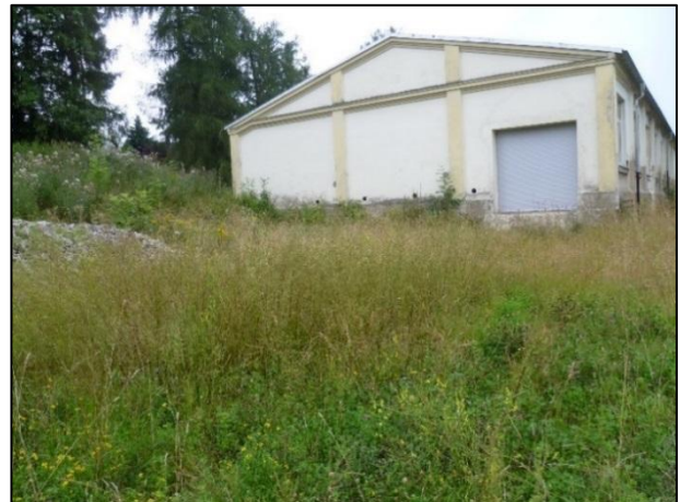
Abbildung 3: Gebäude der ehemaligen Stickerei
