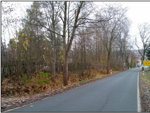
Abbildung 6: Landesstraße mit Böschung und Gehölzen am nördlichen Rand des Plangebietes
