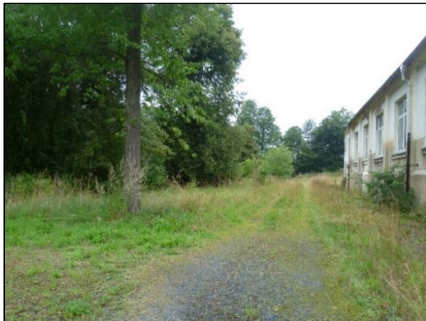
Abbildung 2: Vorhabengebiet (Blick von Süd nach Nord)
