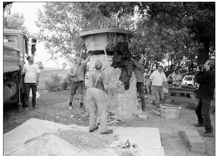
eingesetzt. Danach konnte die Betonplatte mit einem Autokran wieder aufgesetzt und die vorhandenen Fugen ausgemauert werden. Als Letztes erhielt der restaurierte Stumpf einen neuen Außenputz und es wurde eine Gedenktafel mit den wichtigsten Daten des Stelzenbaumes angebracht. Diese Arbeiten konnten rechtzeitig vor dem Tag des offenen Denkmals am 10. September 2006 abgeschlossen werden. Dieser Tag war für die feierliche Enthüllung des restaurierten Stelzenbaumes vorgesehen.
