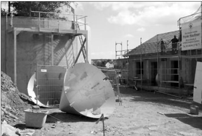
Im Zusammenhang mit dem Kläranlagenbau entstand oberhalb des alten Schlängelgrabens in den Beuten ein Regenüberlaufbecken. Es dient als Entlastungsbauwerk zur Reduzierung des Mischwasserabflusses aus dem Ortsnetz Tanna in den neuen Verbindungssammler nach Frankendorf und hat ein Speichervolumen von 491 m<sup>3</sup>.
