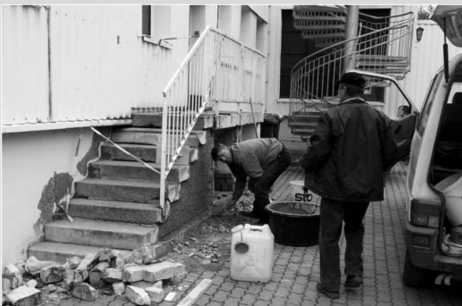
Reparatur Treppe Kita Tanna
