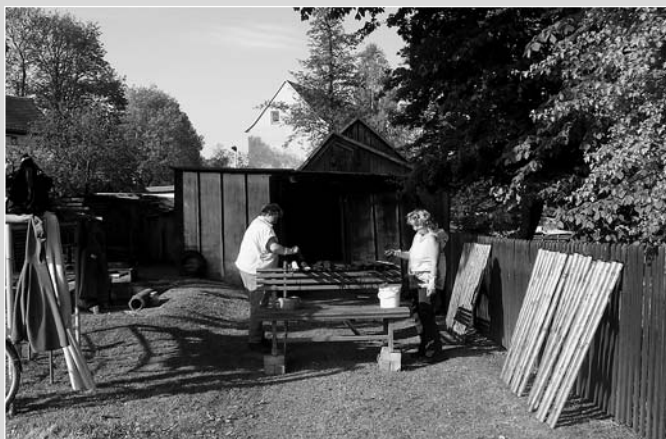
Streicharbeiten für Zaunbau
