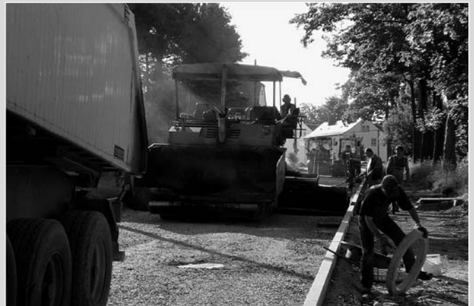
Bau der Bahnhofstraße
