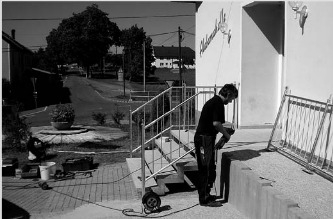
Bau Eingangsbereich Alabamahalle
