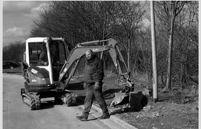
Reparaturarbeiten an der Zufahrt zum Gewerbegebiet
