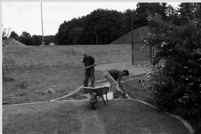
Ausbau der Anlagen am Beachplatz
