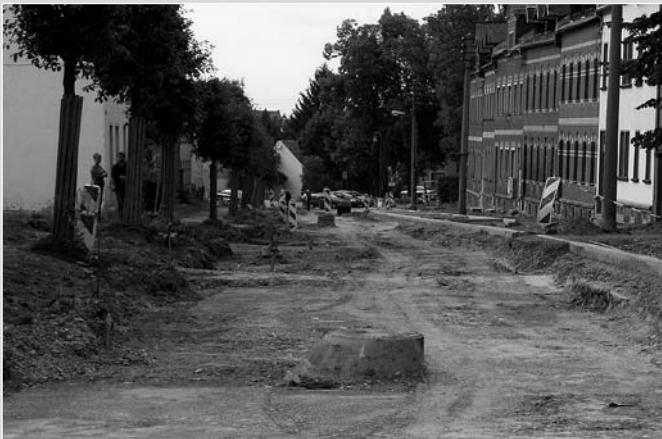
Bau der Bahnhofstraße
