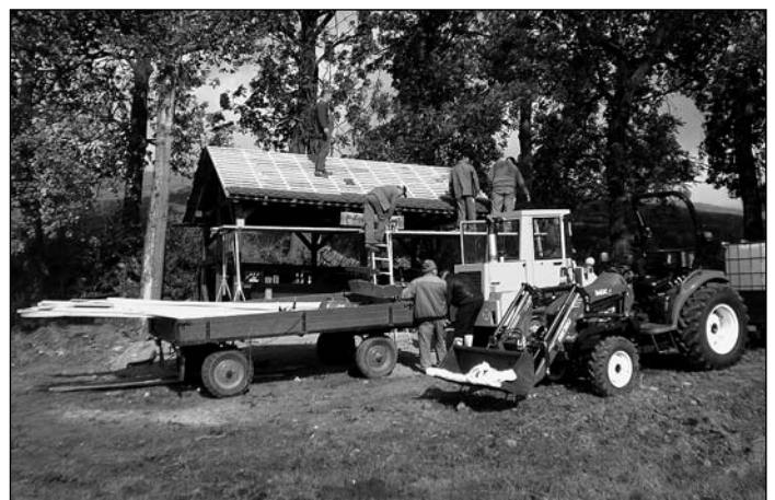
Bau der Schutzhütte
