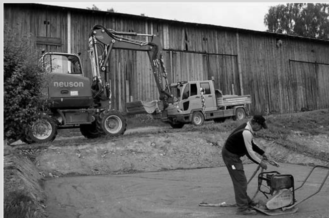
Bau neuer Stellplätze vor der Kita Zollgrün
