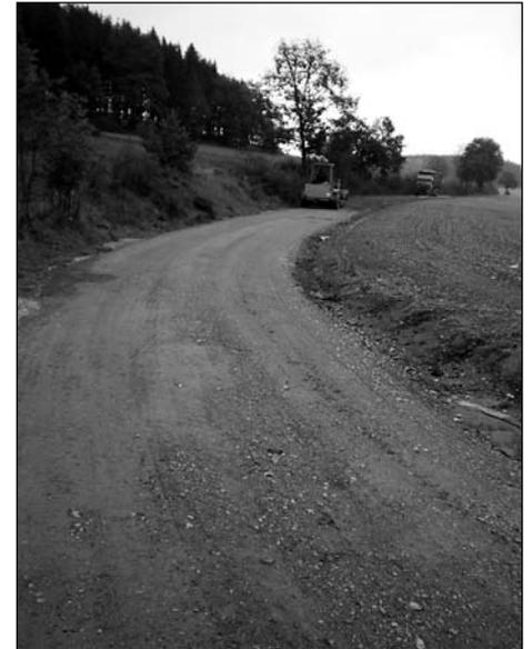
Bereits im Frühjahr wurde der Weg vom Ebersberg nach Oberkaskau bis zum Ausgang des Waldabschnitts mit Fräsgut ausgebaut.
